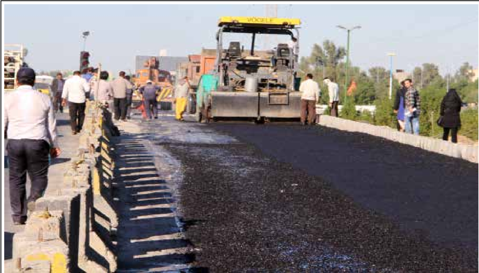
آسفالت باند شمالی پل سوم (پل شهید دقایقی) - عکس: مسعود شیوطی
